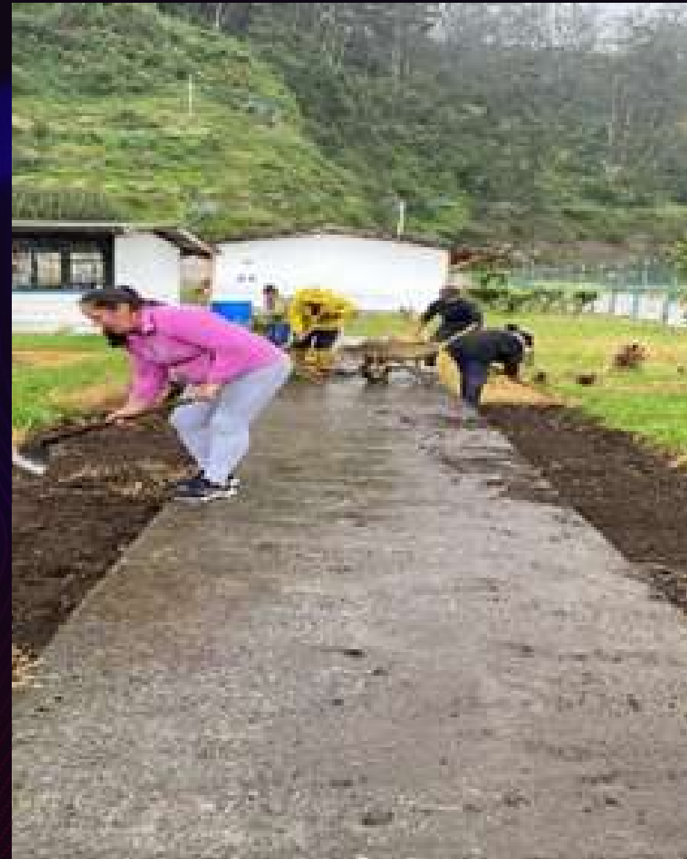
LIMPIEZA Y PREPARACIÓN DEL TERRENO
